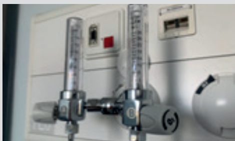
Figura 7 A e B – Debitómetro de \text{O}_2 duplo (15 e 30L/min)
